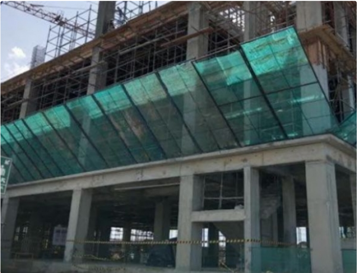
Gedung baru RSUD dr Soedomo dalam pembangunan
